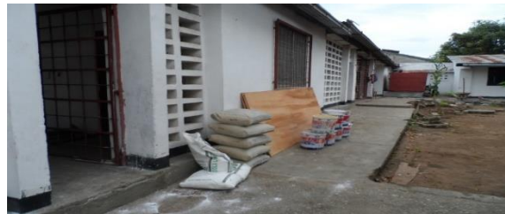
ciment, triplex pour plafonds, boîtes et brosses de peintures/ cement, triplexplaten voor de plafonds, dozen verf en borstels
