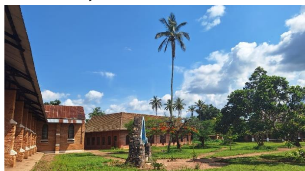
des bâtiments à Mikalayi / gebouwen in Mikalayi
