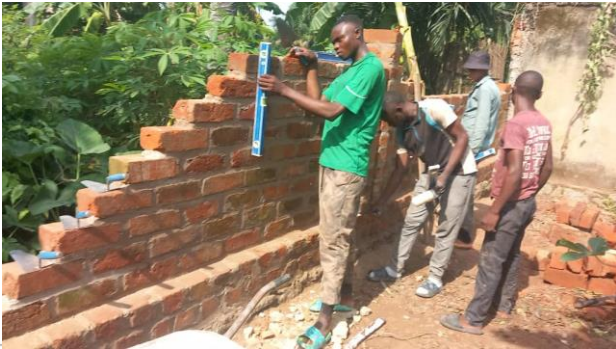
de muur wordt hersteld/la réparation du mur
