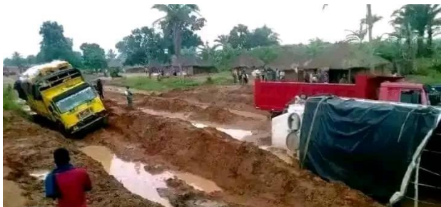
verzakking van de weg/erosions de route
