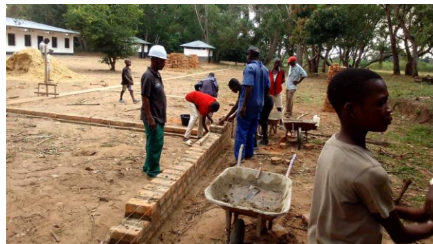
les premières briques sont posées/de eerste stenen zijn gelegd
